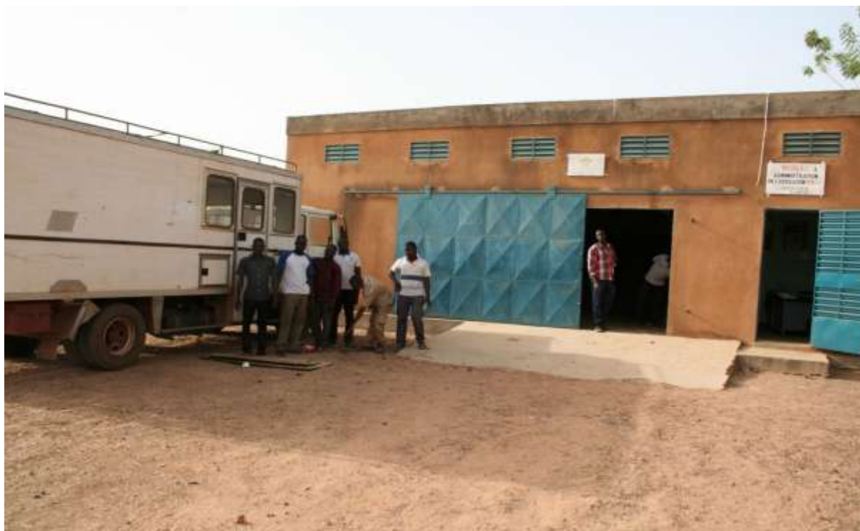
Fin de chantier vers 17h.
