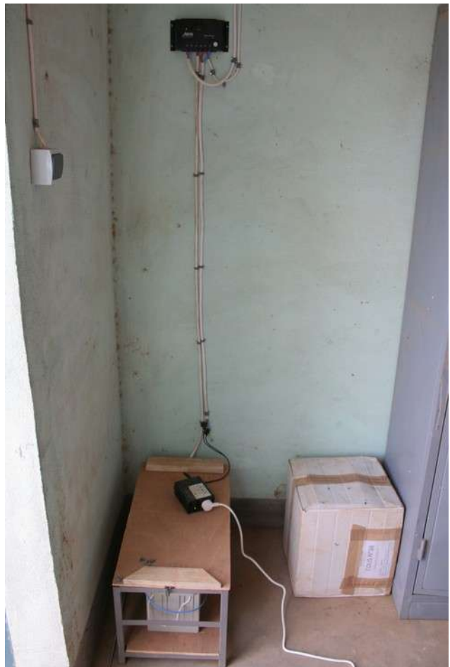
Le régulateur STECA PRS2020, la batterie de 150Ah et le convertisseur 150W
