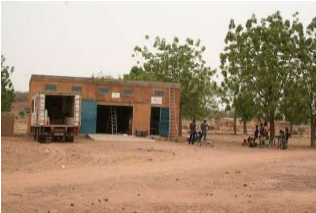
Début du chantier vers 11h
