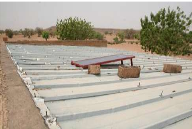
Position du panneau sur le toit
