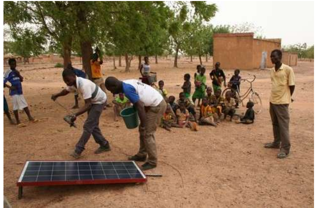
Fixation du panneau Luxor de 140Wc dans le cadre anti vandalisme
